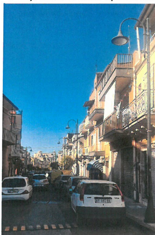
8 - Corpo illuminante di arredo urbano
